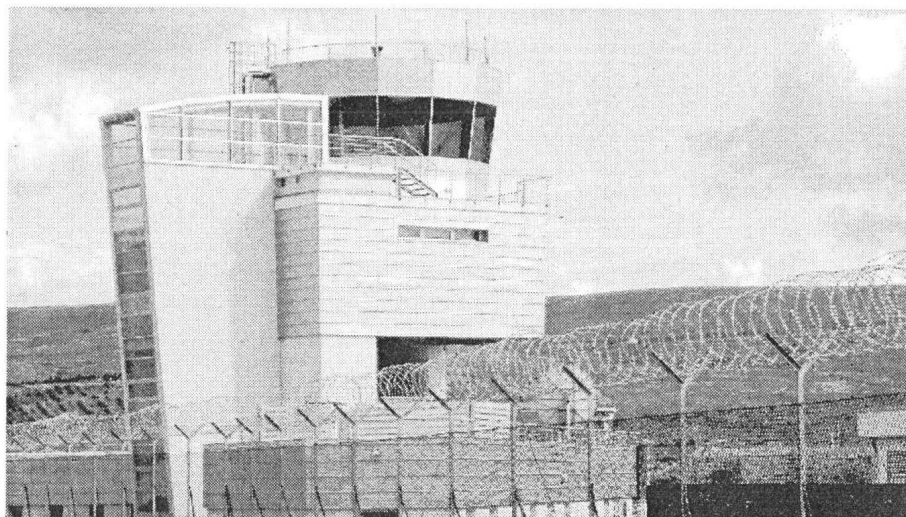
La torre di controllo del nuovo aeroporto di Comiso
